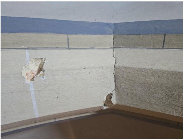
Risse und Abplatzungen im Sandstein und Putz
