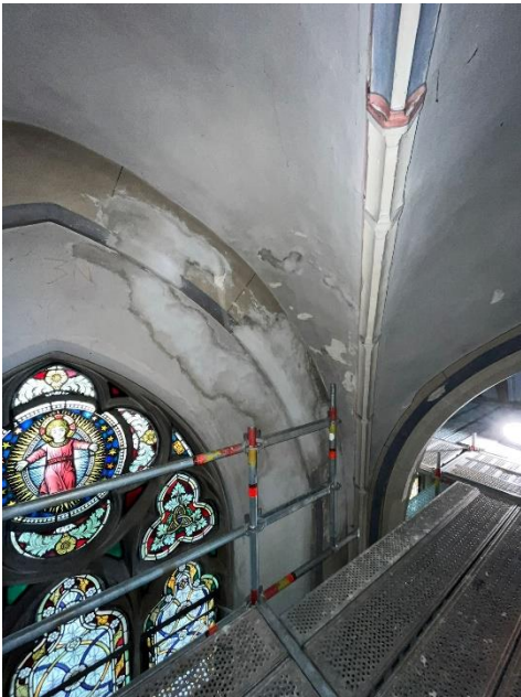
Wasserschäden am Putz
